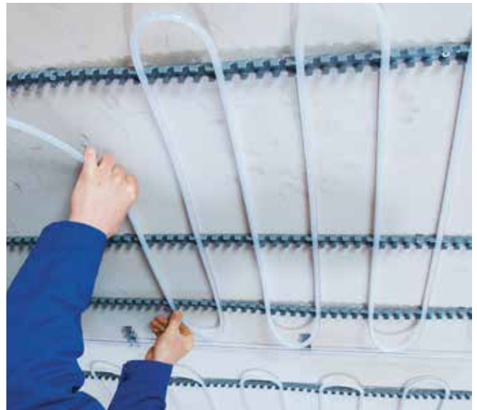
Anschließend werden die Systemrohre möglichst drallfrei in die Uponor Fix Klemmschienen eingedrückt. Bei Bedarf können abstehende Rohrschlaufen im Umlenkungsbereich zusätzlich mit Schienenstücken fixiert werden.
