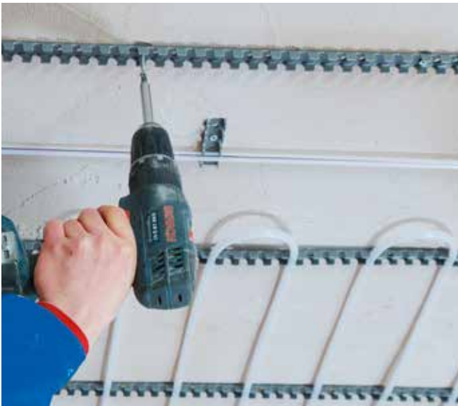
Zunächst werden die Uponor Fix Klemmschienen unter der tragenden Decke in dem vorgegebenen Abstand befestigt. Kurze Schienenstücke können dabei auch zur Befestigung der Zuleitungen verwendet werden.
