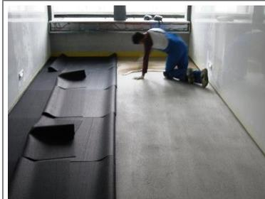
Die Elastikmatten **mind. 24 Stunden entspannen und akklimatisieren lassen**.
