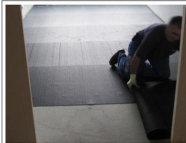
Prüfen und Vorbereiten des Untergrundes. Kugelstrahlen bzw. Absanden, ev. und falls nötig, auch eine Grundierung auf Epoxydbasis vorsehen.
