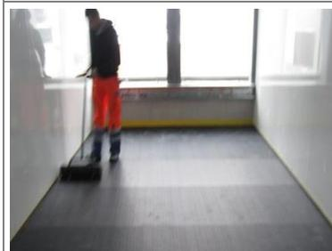
Abschliessend die Elastikmatten walzen und Klebstoff nach Herstellerangaben trocknen lassen.
