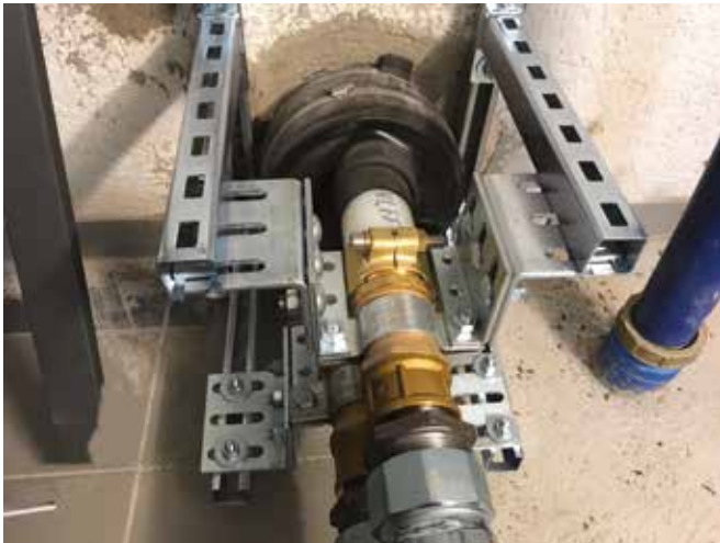
Optimal ausgeführter Fixpunkt mit Wipex-Fixpunktmuffen und Fixpunktschellen für ein Ecoflex VIP Thermo Twin Rohr 2x75x6,8/250
