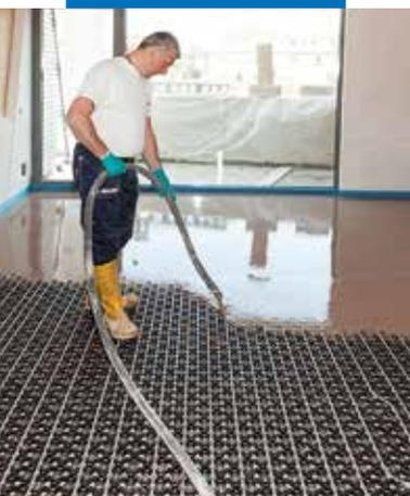
Verwendung von Novoplan Maxi zur kompakten Einbettung von Heizsystemen
