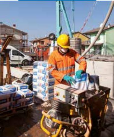
Anmischen und Fördern von Novoplan Maxi mittels Pumpentechnik
