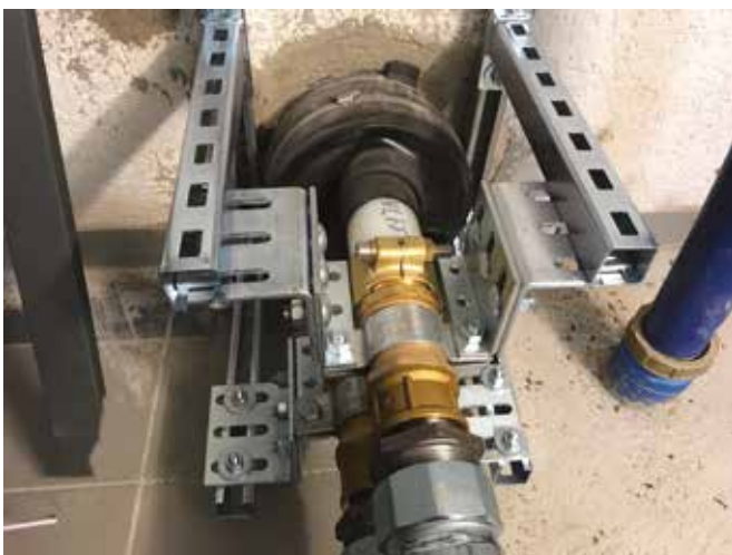
Fixpunkt – Beispielausführung mit Wipex-Fixpunktmuffen und Fixpunktschellen für ein Uponor Ecoflex VIP Thermo Twin Rohr 2x75x6,8/250
