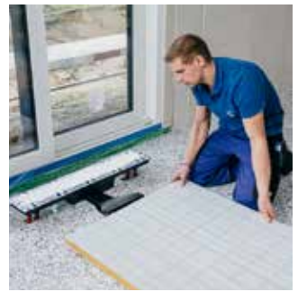
Einstecken des Comfort Air Panels in den Pluggit Comfort Air Adapter
