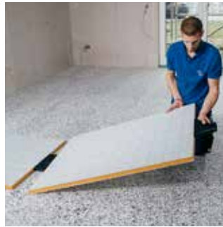
Einstecken des Pluggit Comfort Air Adapters
