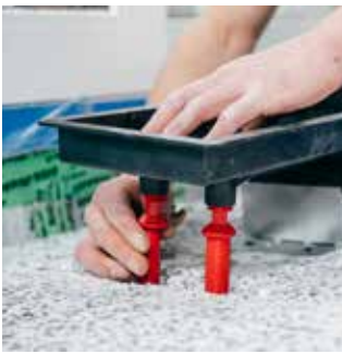
Montage der Pluggit Zuluftauslässe
