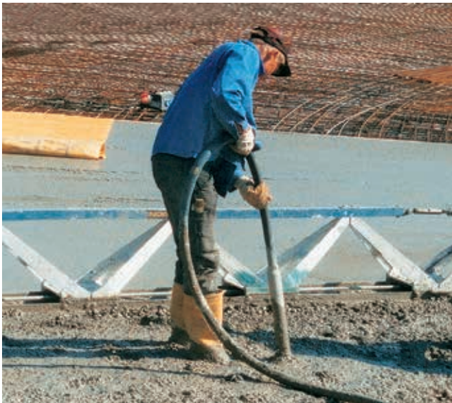
Betonverdichtung durch Rüttelflaschen
