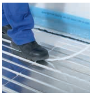
Die Uponor Systemrohre werden anschließend in die Omega-Nut der Wärmeleitlamellen eingedrückt.
