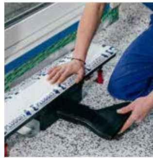
Einstecken des Pluggit Comfort Air Adapters
