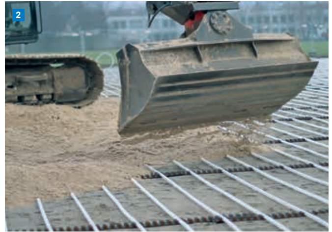
2 Die robusten 5-Schicht Uponor PE-Xa Rohre erlauben sogar den Überkopfeinbau der Drain- und Rasentrageschicht.
