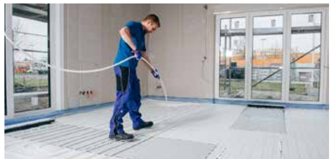
Nach Montage des Comfort Air Systems erfolgt abschließend die Verlegung der Uponor Klett Fußbodenheizung/-kühlung
