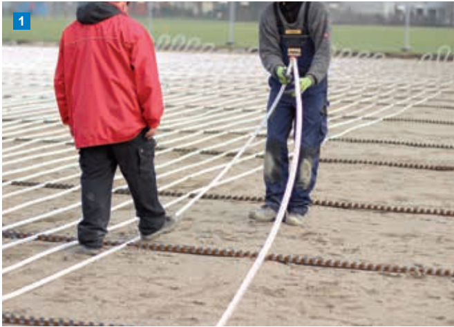
1 Verlegung der Tragschienen und der Uponor Neva Systemrohre im berechneten Verlegeabstand auf dem vorbereiteten Untergrund.
